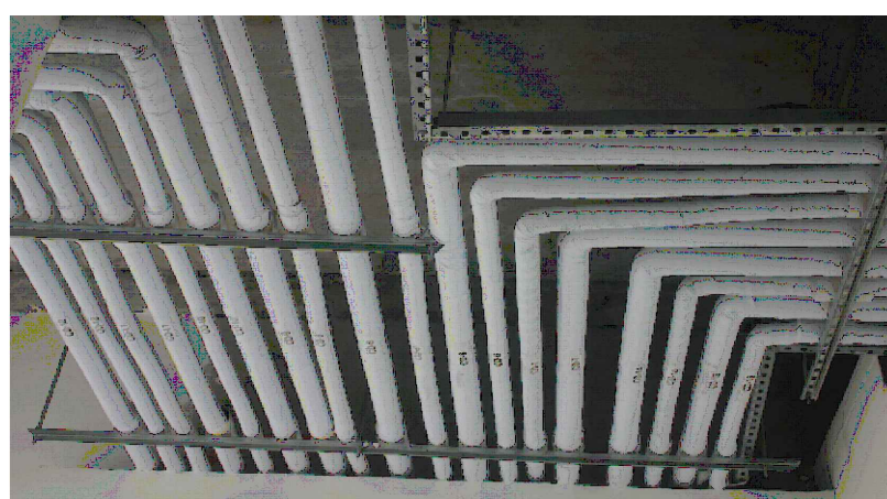
DETALHE SUPPORTO, AMARRAÇÃO, IDENTIFICAÇÃO SEM ESCALA
