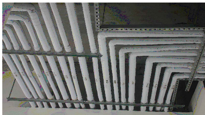
DETALHE SUPPORTE, AMARRAÇÃO, IDENTIFICAÇÃO SEM ESCALA
